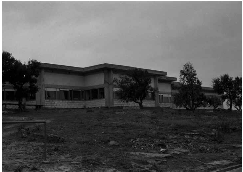
111. Borgo di Dio, Trappeto, fotografia dell'edificio appena realizzato, 1968 (Archivio Borgo di Dio a Partinico, Palermo).
