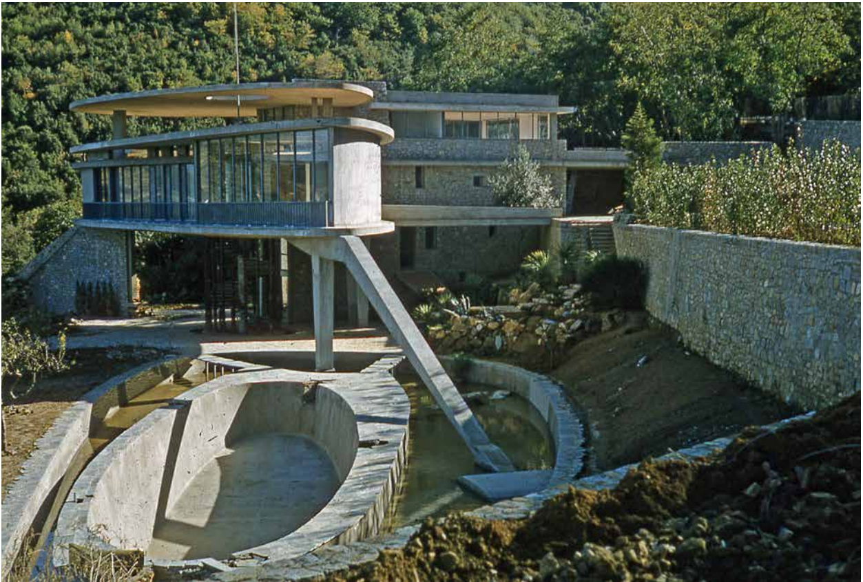
71. Casa per Pierre Balmain all'isola d'Elba, 1958: lavori appena ultimati (foto: Ricardo Scofidio, casa-studio Ricci, Monterinaldi).
