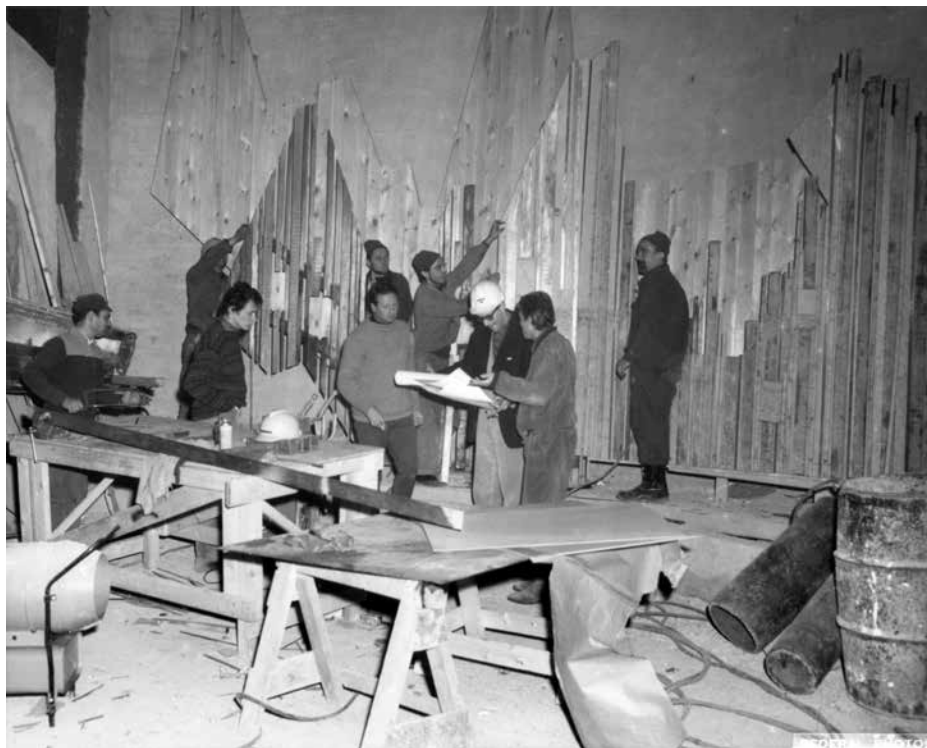
132. Padiglione italiano per l'Expo di Montréal, 1967: Ricci in cantiere per l'allestimento della sezione del 'costume' (foto s.a., casa-studio Ricci, Monterinaldi).
