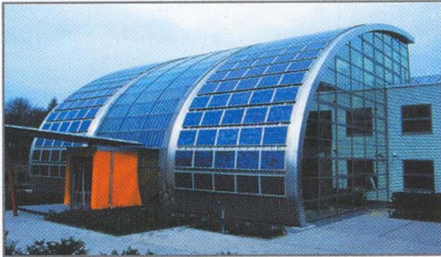
Fabbrica di celle solari a Gelsenkirchen, Germania Moduli - Flabeg Sistema di fissaggio - Conergy System.
