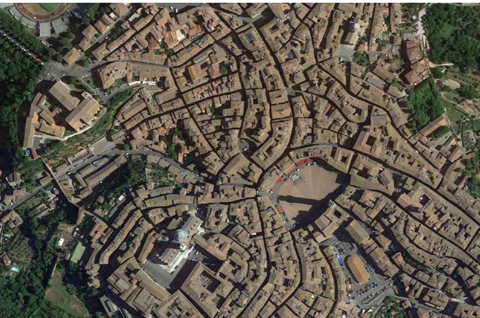
[Immagine 8] La città gerarchica . Veduta aerofotogrammetrica del centro della città di Siena (Google Earth)
